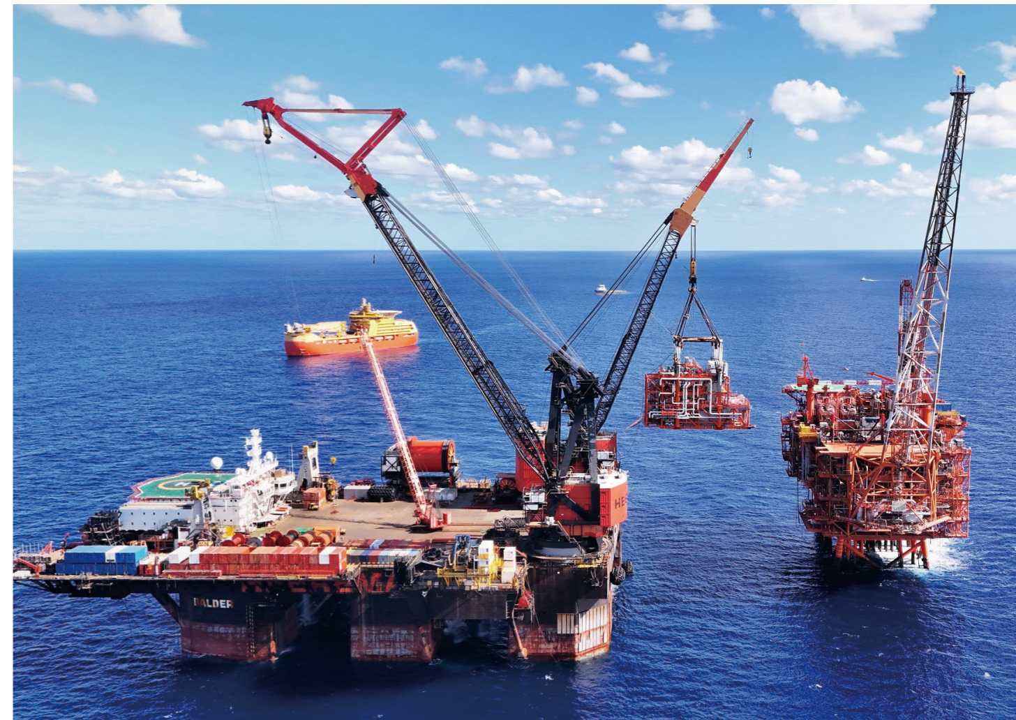
本集團國際貨運分部旗下的 KLN Project 於二零二五年十月在利比亞水域的塞卜拉泰海上平台，完成了 1,700 噸天然氣壓縮模組的一站式離岸運輸及安裝服務
